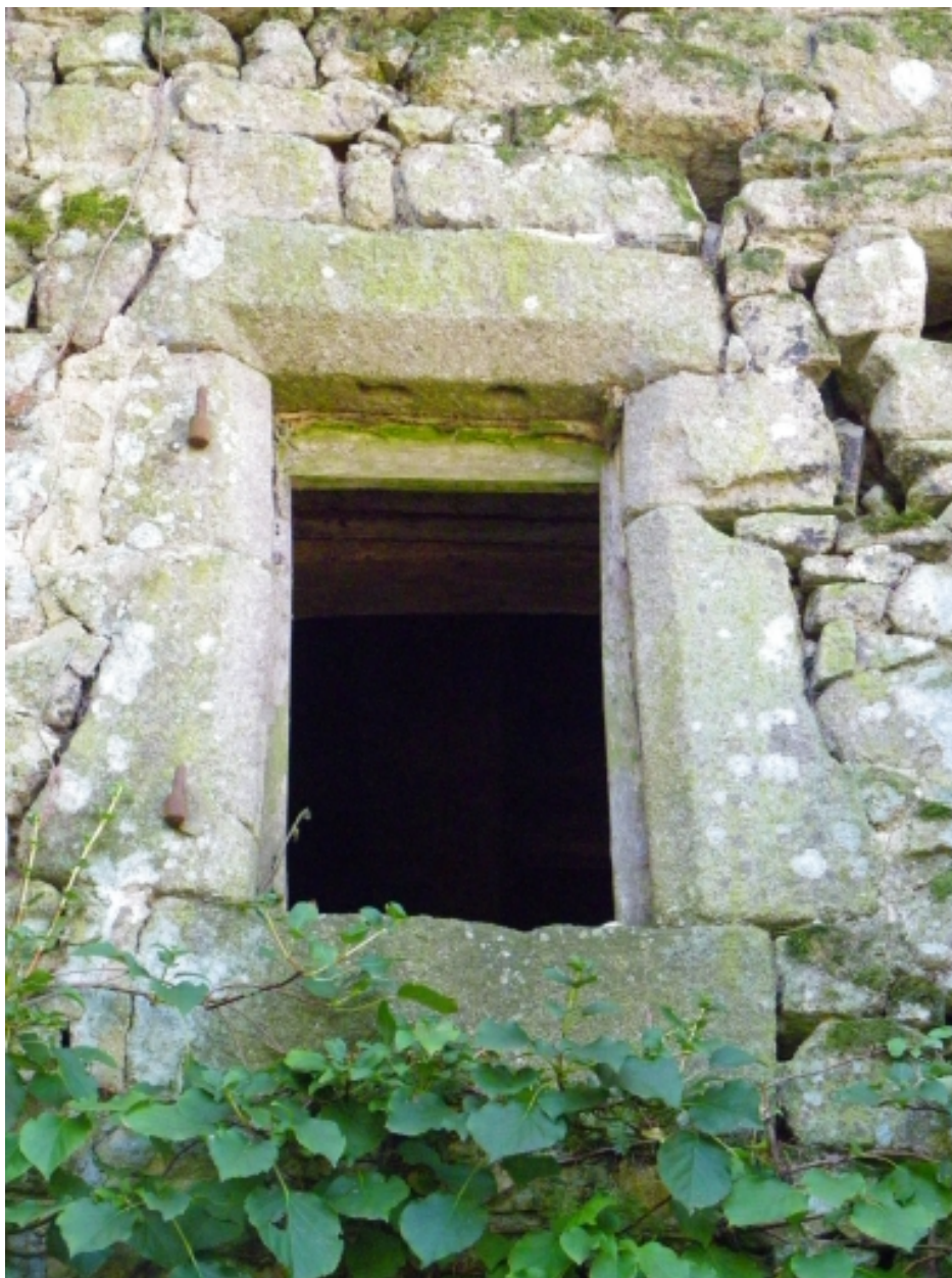
Chambre des Coëtlogon, fenêtre de l'étage.
