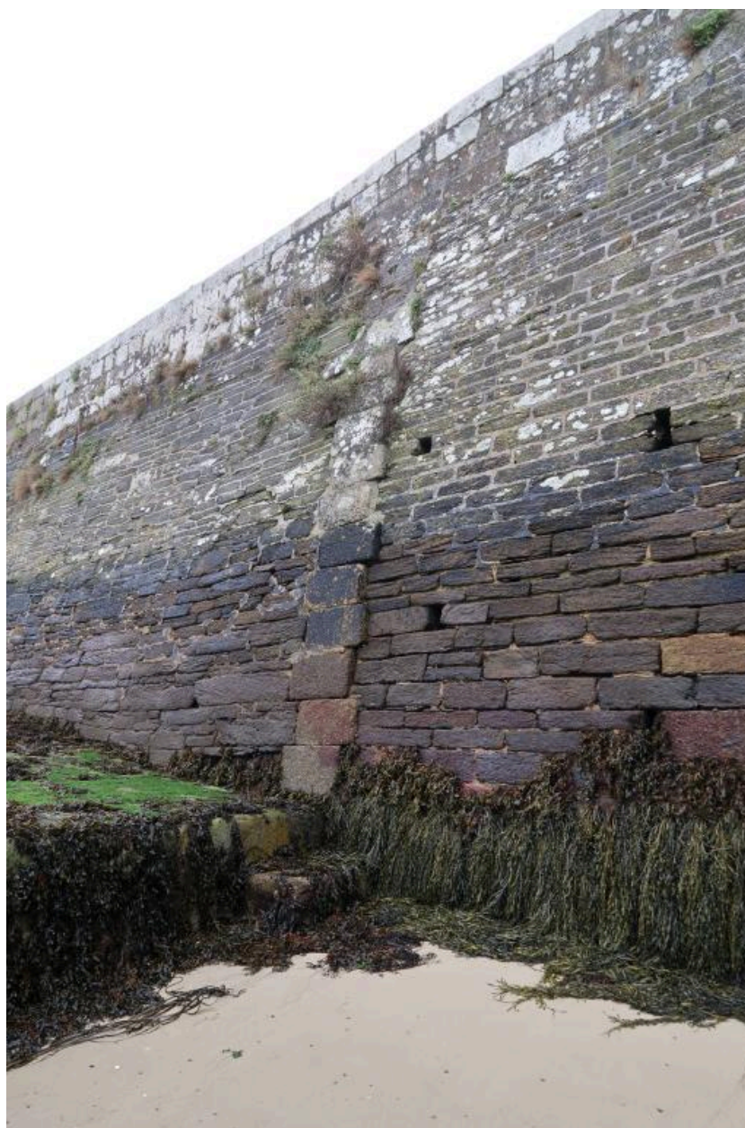
Mur de soutènement, partie Est du site du Drellac'h
