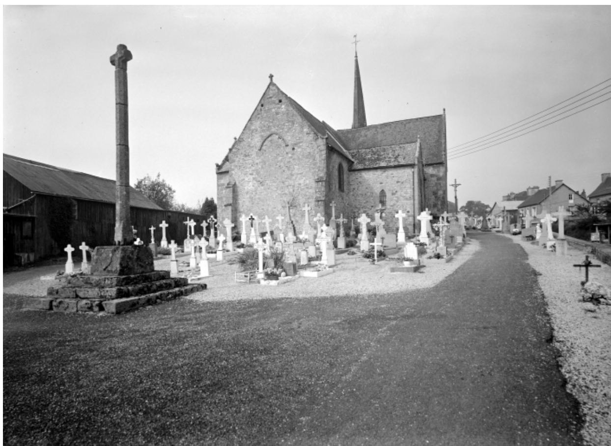
Elévation Nord-Est : vue générale
