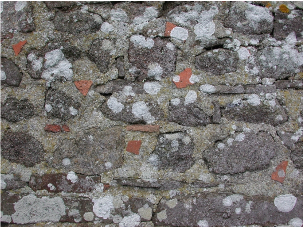
Mur nord de la nef, détail de l'appareillage
