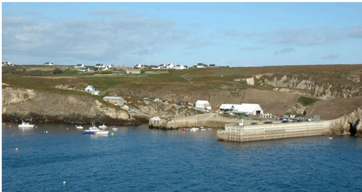
Vue générale du port-abri du Stiff
