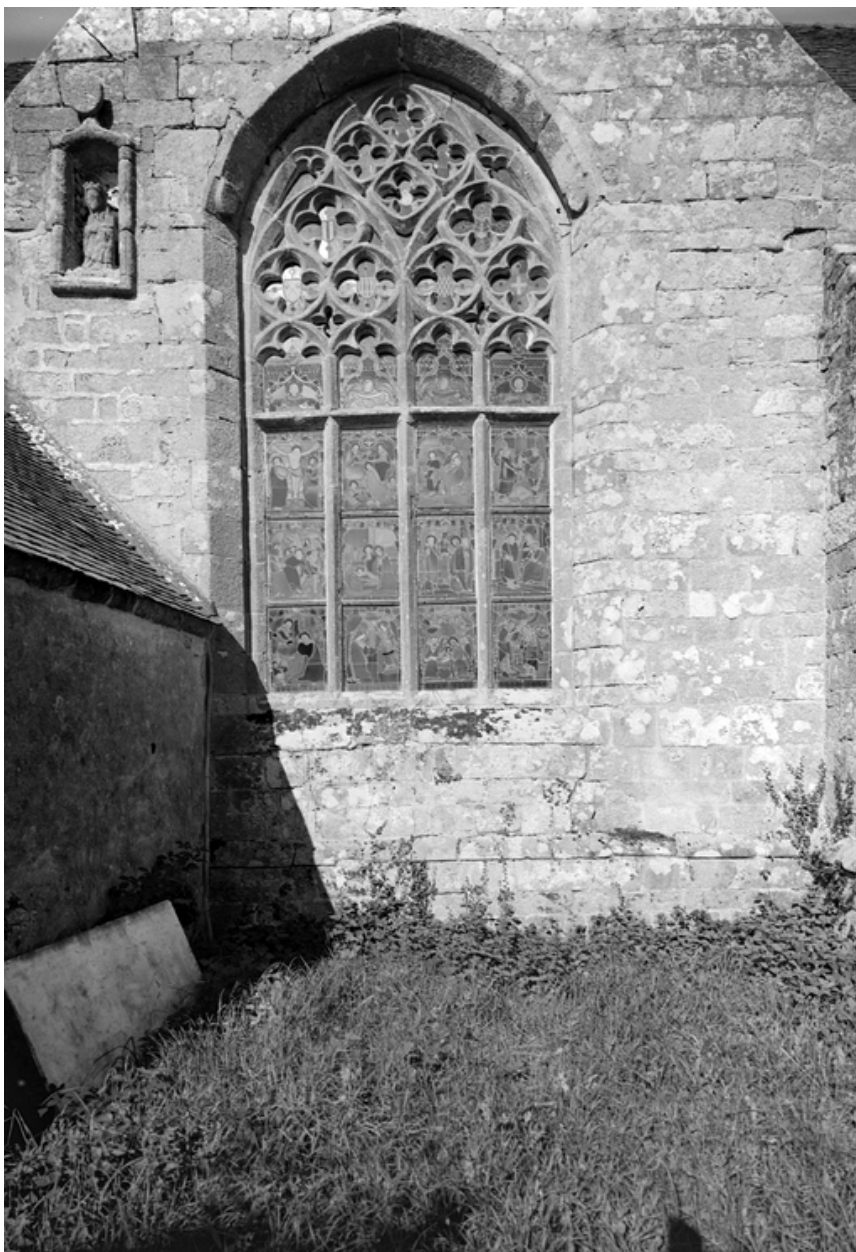
Fenêtre axiale de la face est
