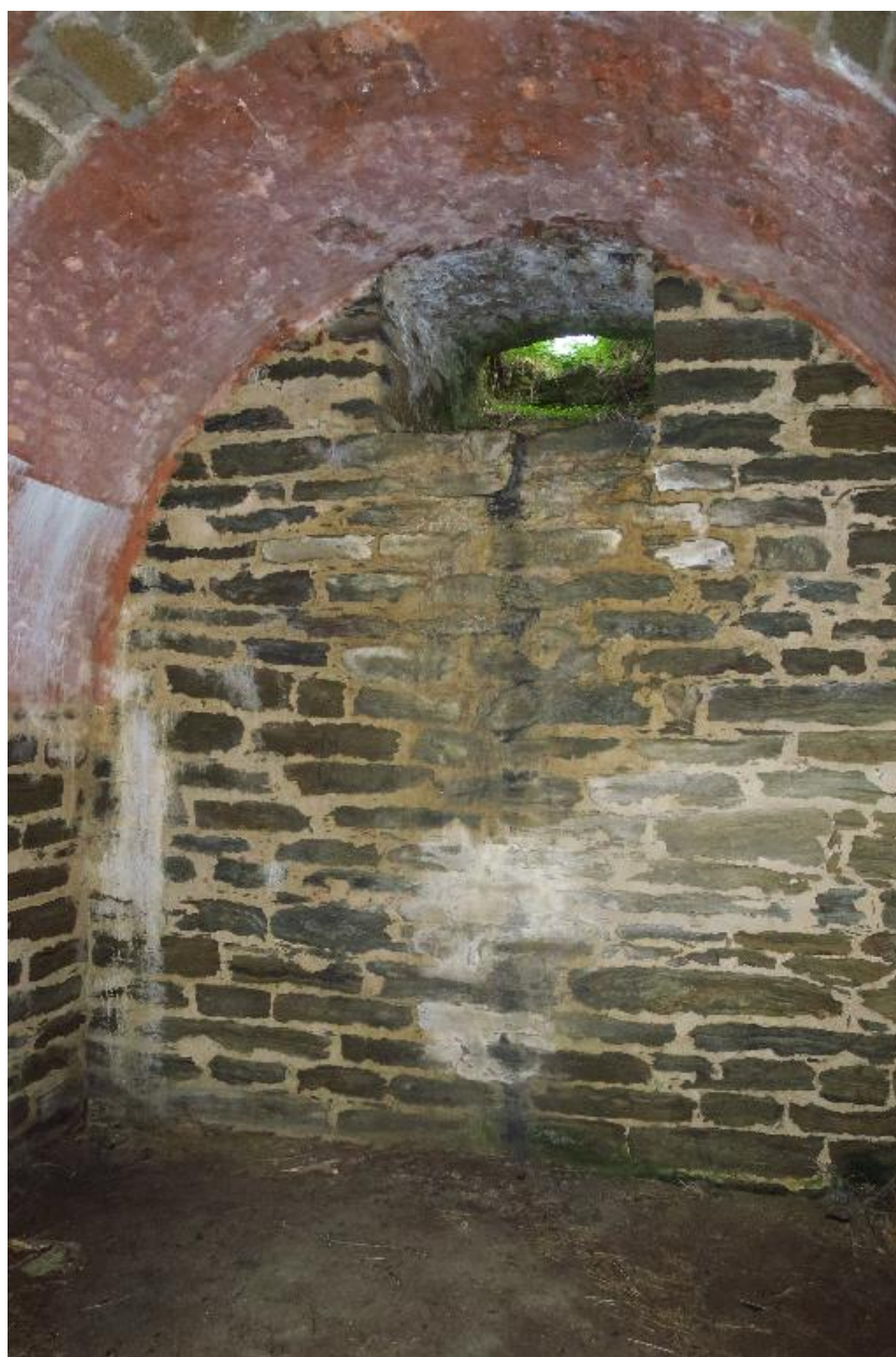
Le Palais, enceinte urbaine, réduit H, casemate d'artillerie, aération.
