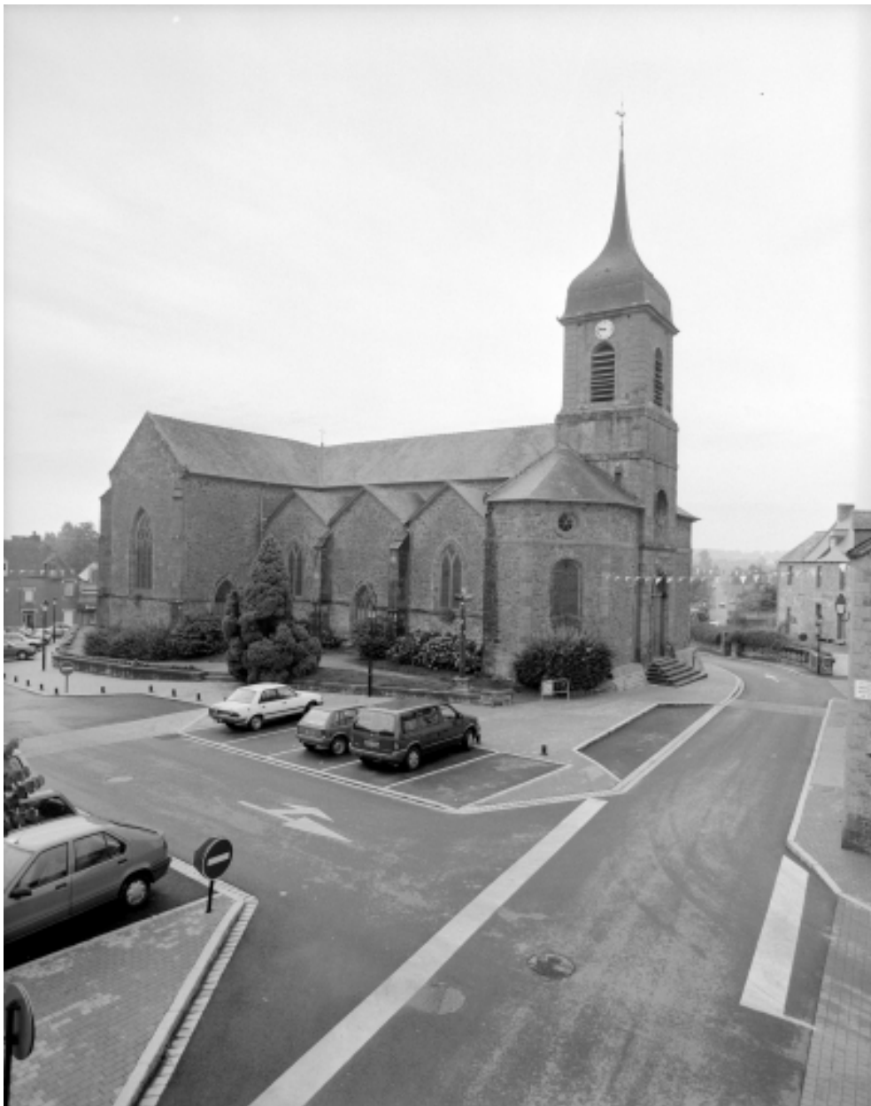
Elévation Nord : vue générale
