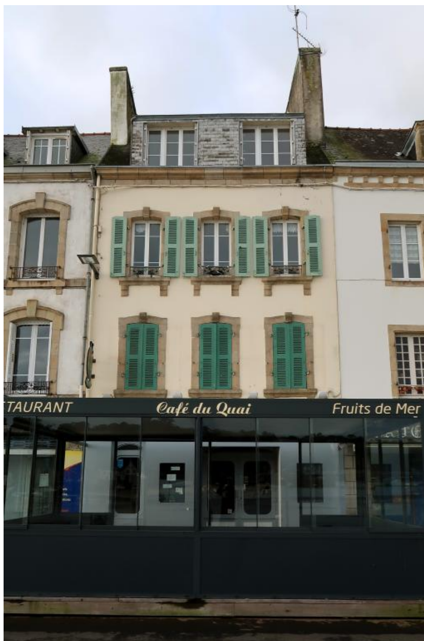
Immeuble au 8, quai Jean Jaurès, élévation antérieure. (2020)
