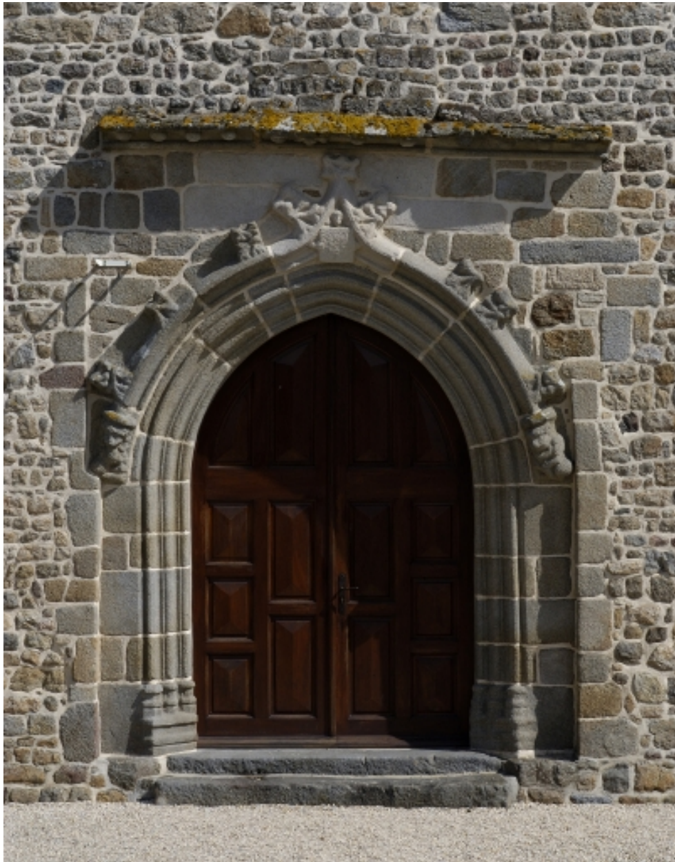
Elévation ouest : détail du porche
