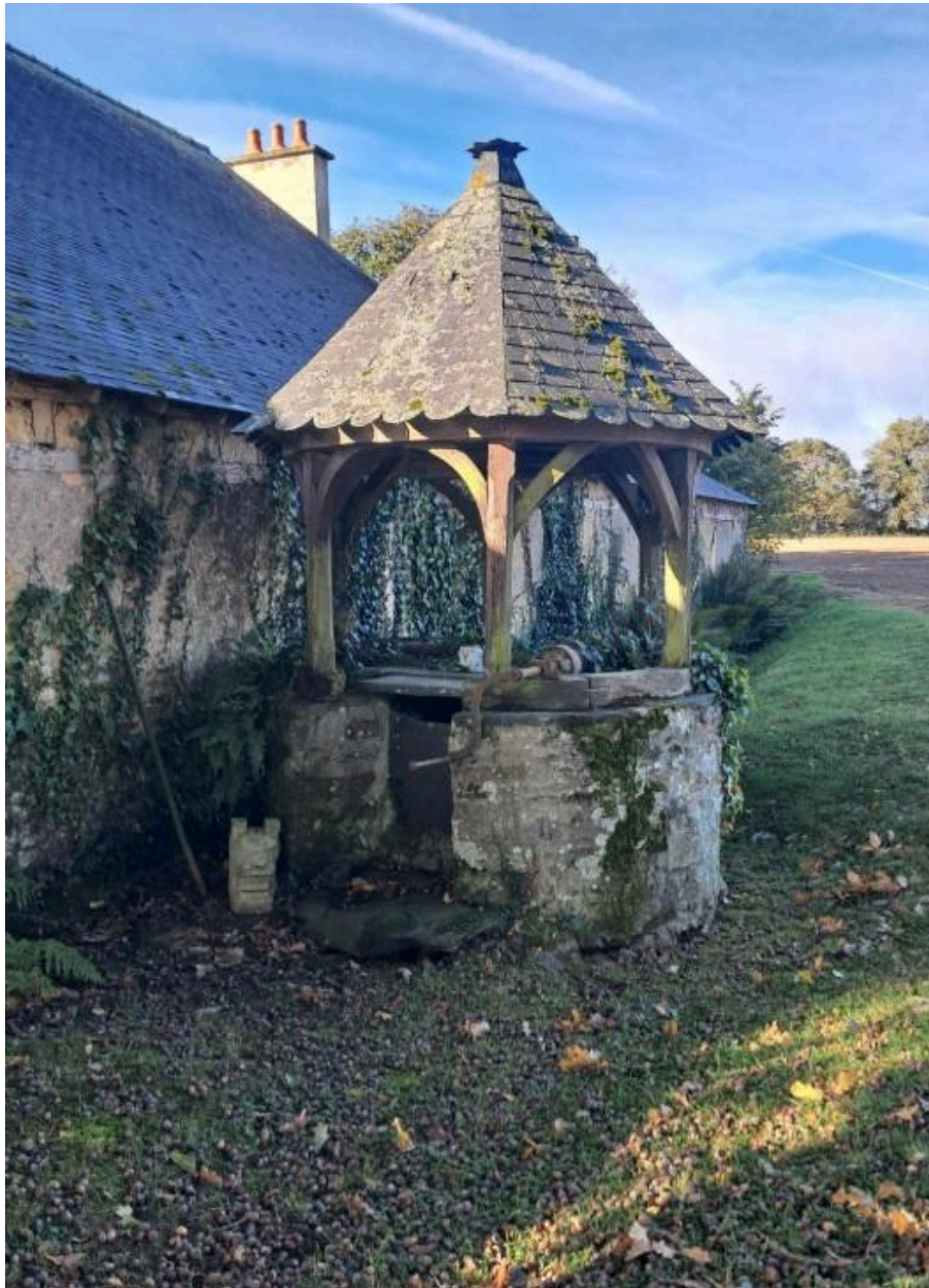
puits ouvragé 3897 Montverron
