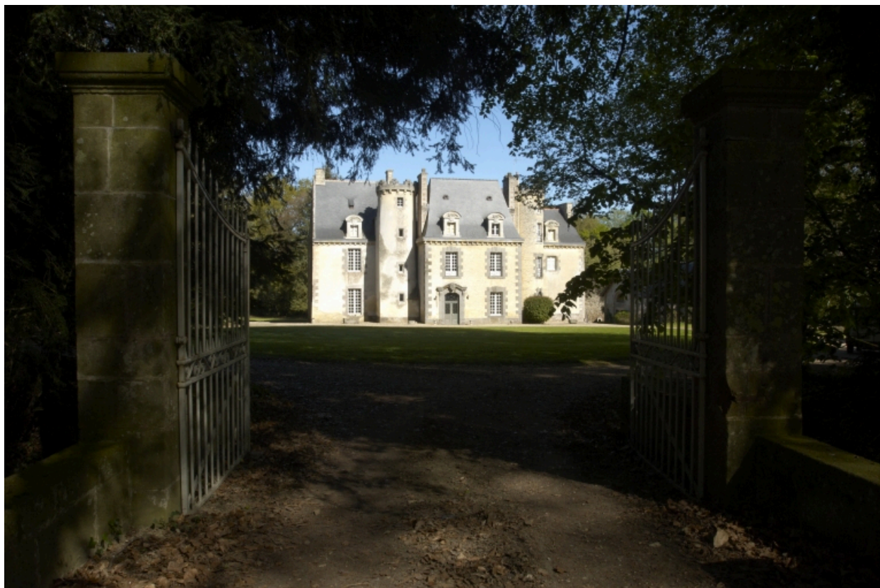
Logis, vue générale de la façade arrière
