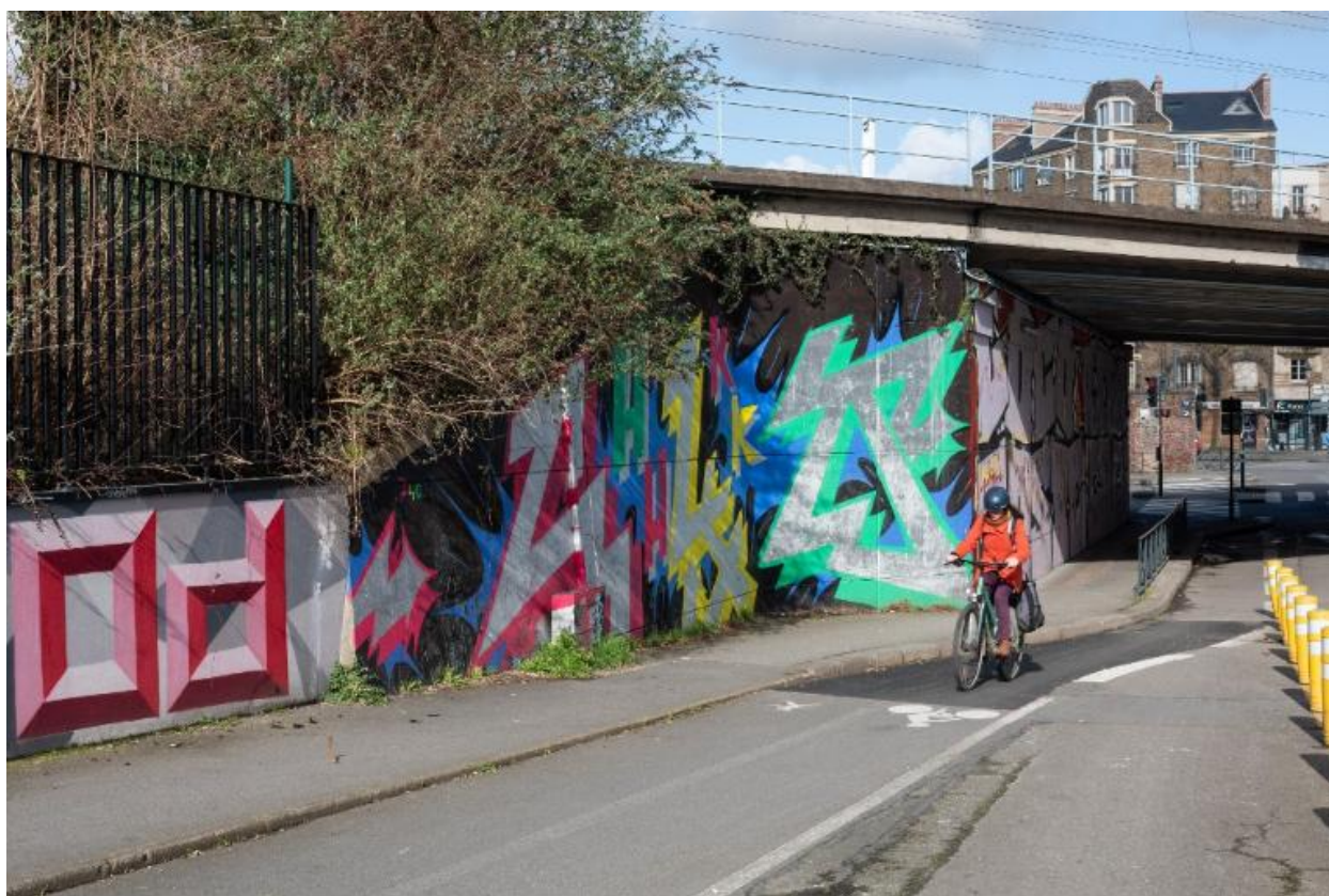
Vue de la culée ouest.
