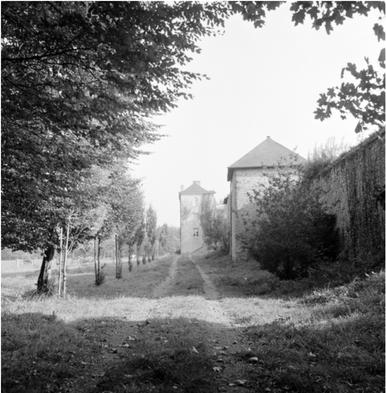
Vue générale nord.
