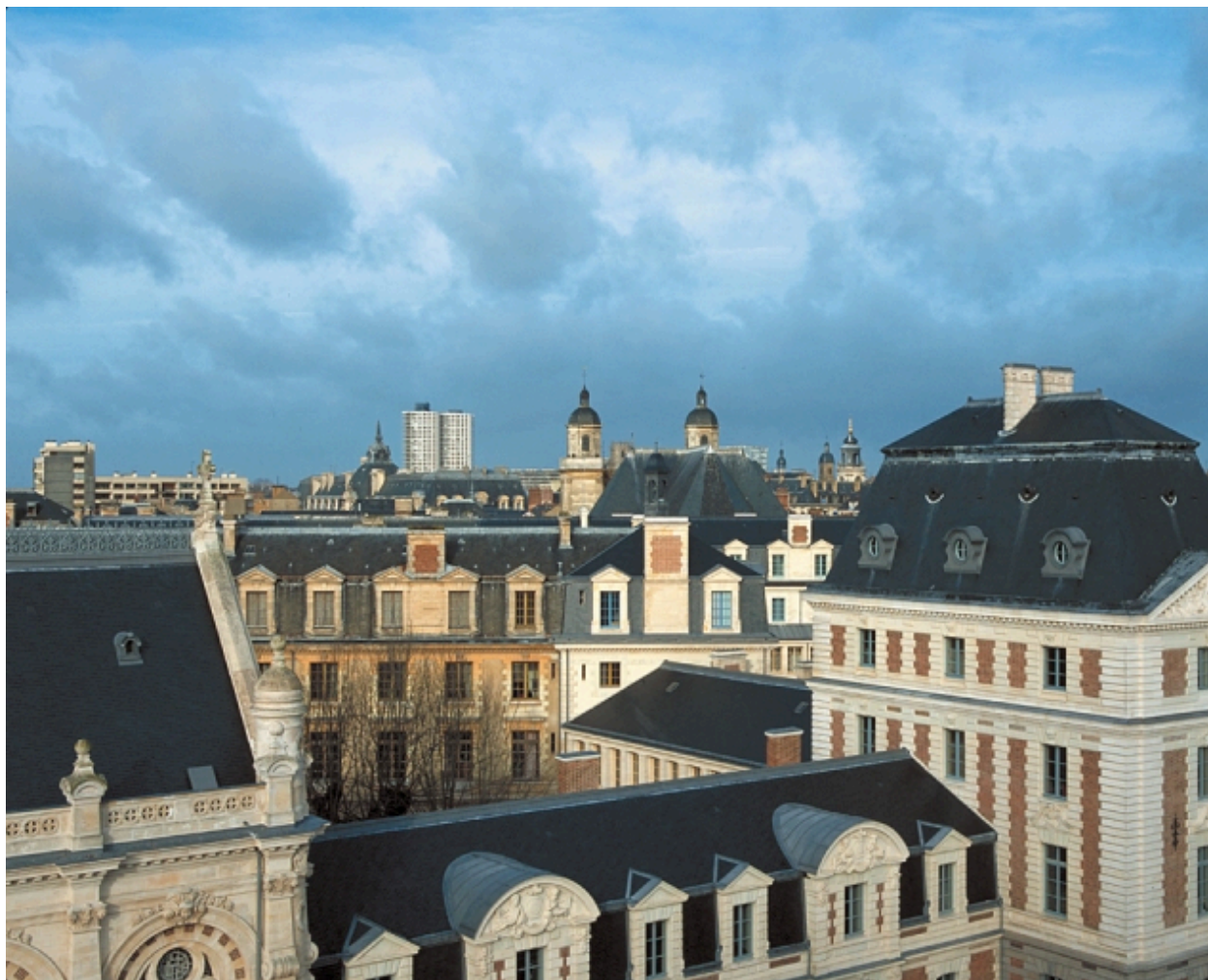
Détail des toits
