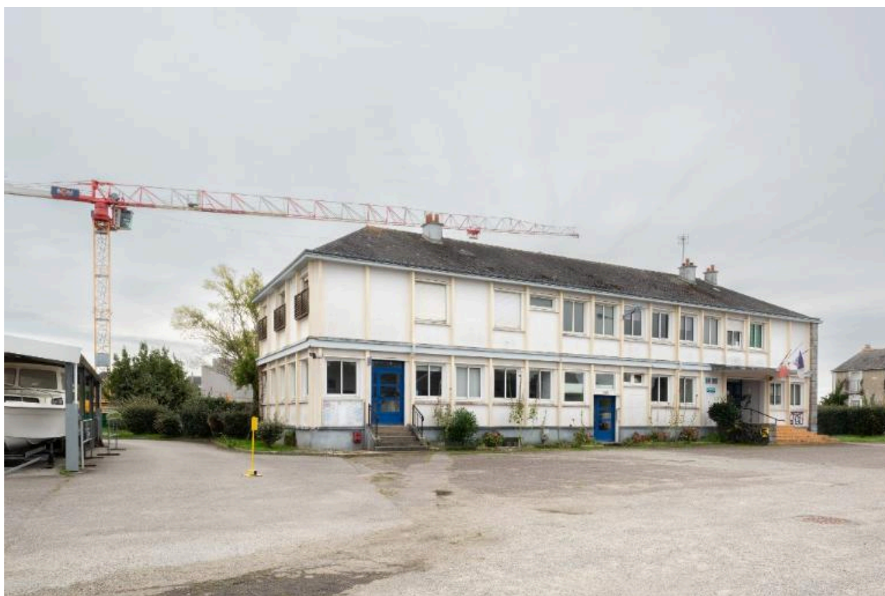
Vue d'ensemble de administration, prise du nord-est. Yves Guillou et Georges Tourry, architectes, 1959.
