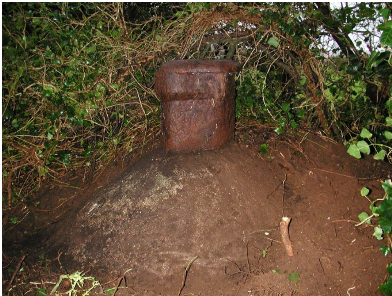
Vue du conduit du périscopes avec son volet blindé
