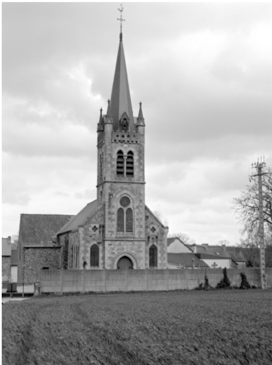
Elévation ouest ; vue générale
