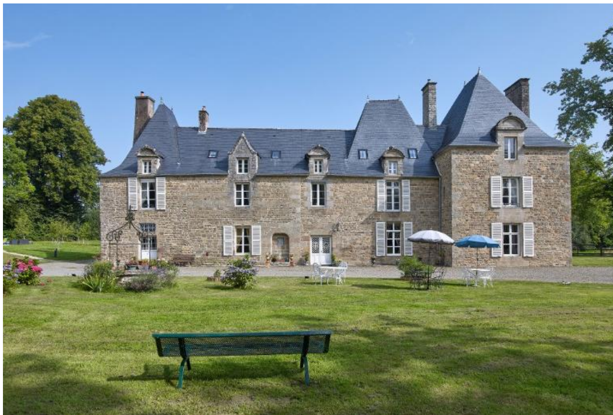
Elévation antérieure orientée vers le sud, vue générale.
