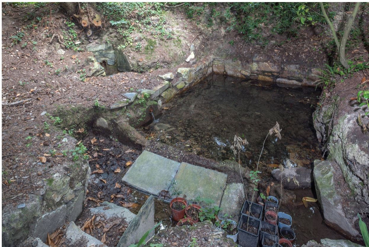
Doué nord. Vue générale
