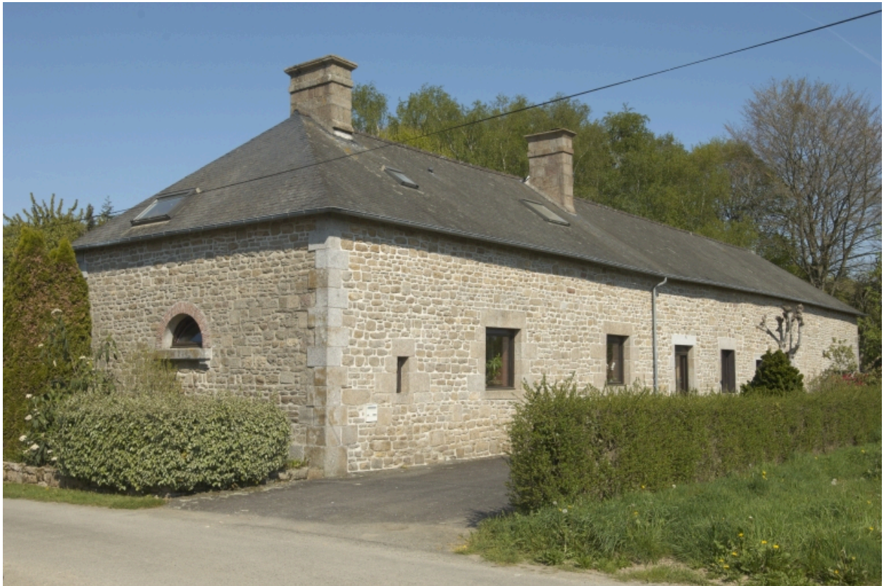
Façade postérieure du commun est.
