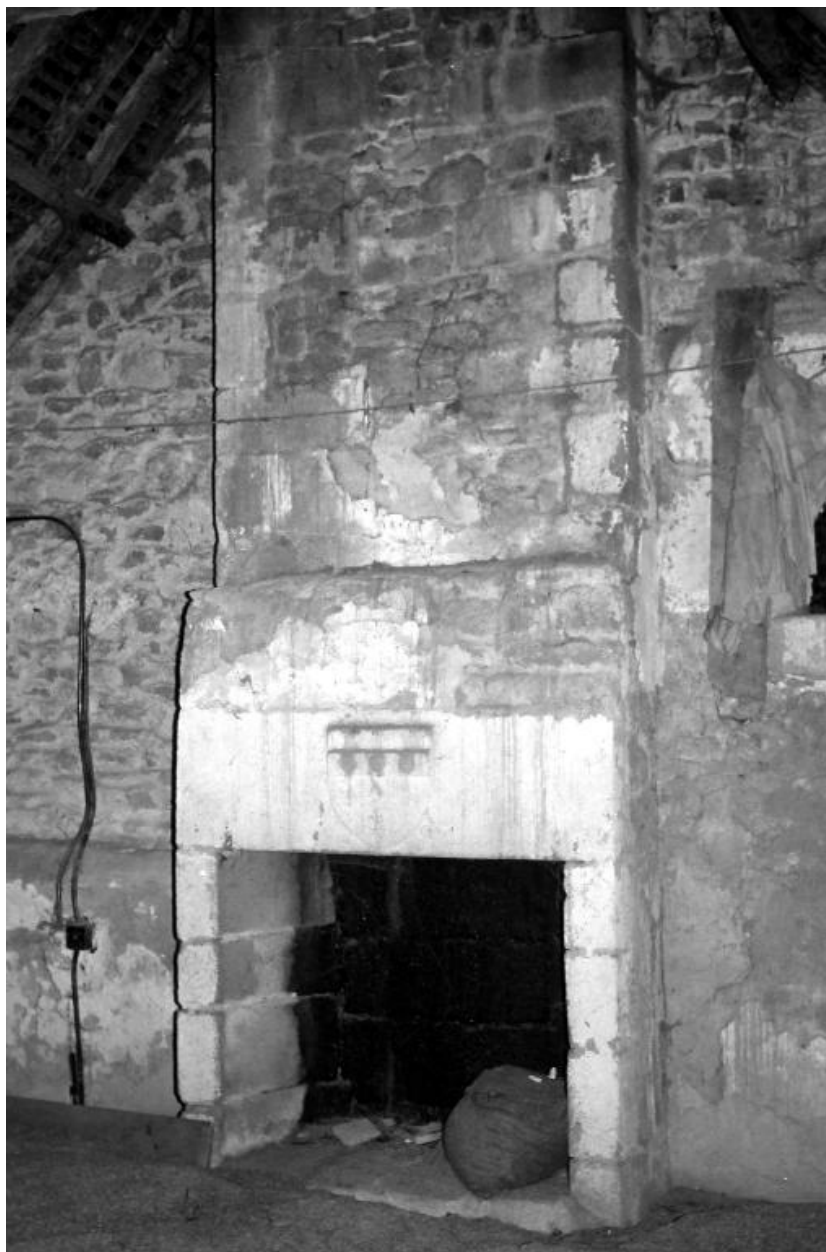
Cheminée au premier étage
