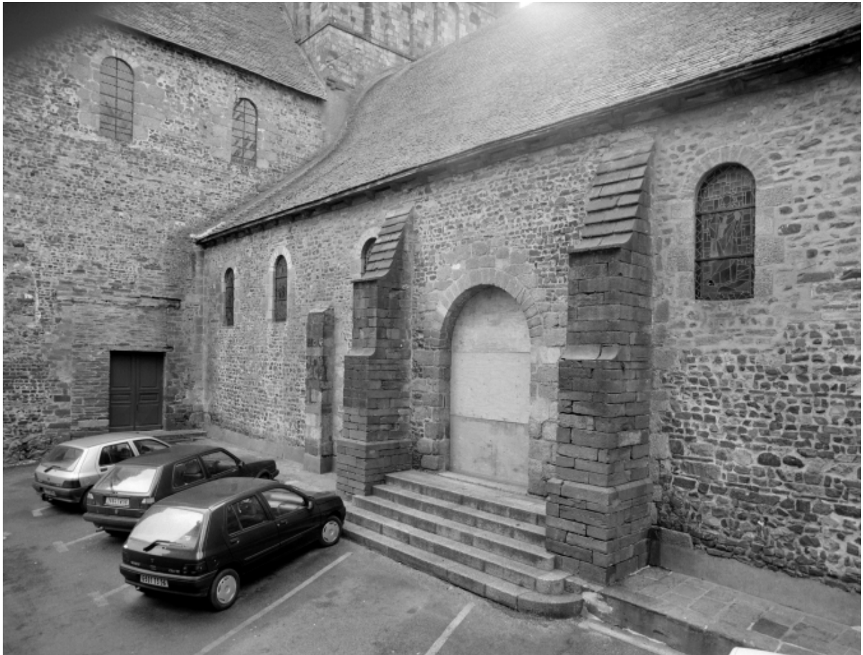
Vue partielle du collatéral nord de la nef et du bras nord
