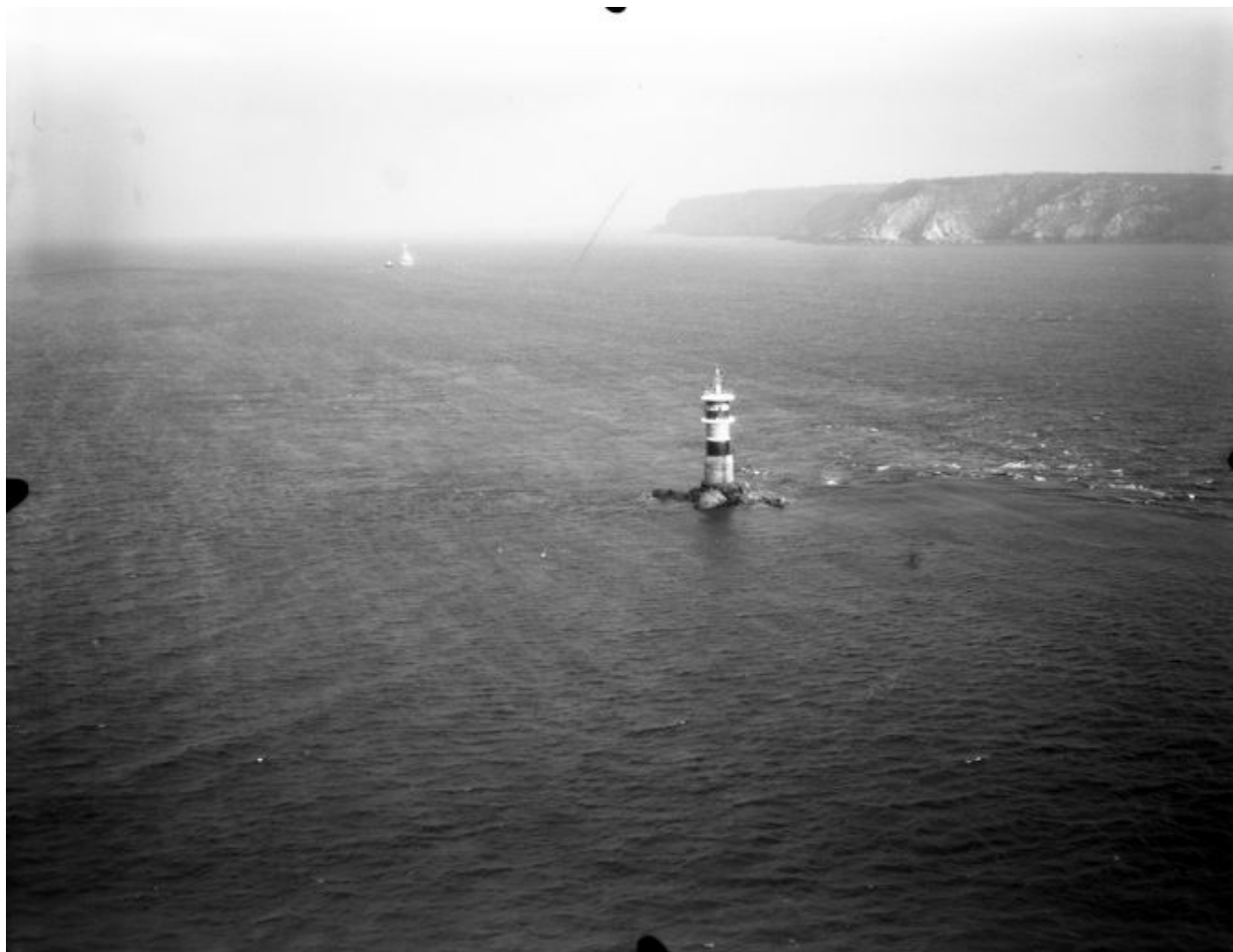
Vue aérienne de la roche du Mengant en 1971
