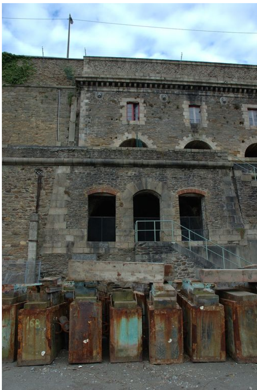
Vue de situation des latrines collectives
