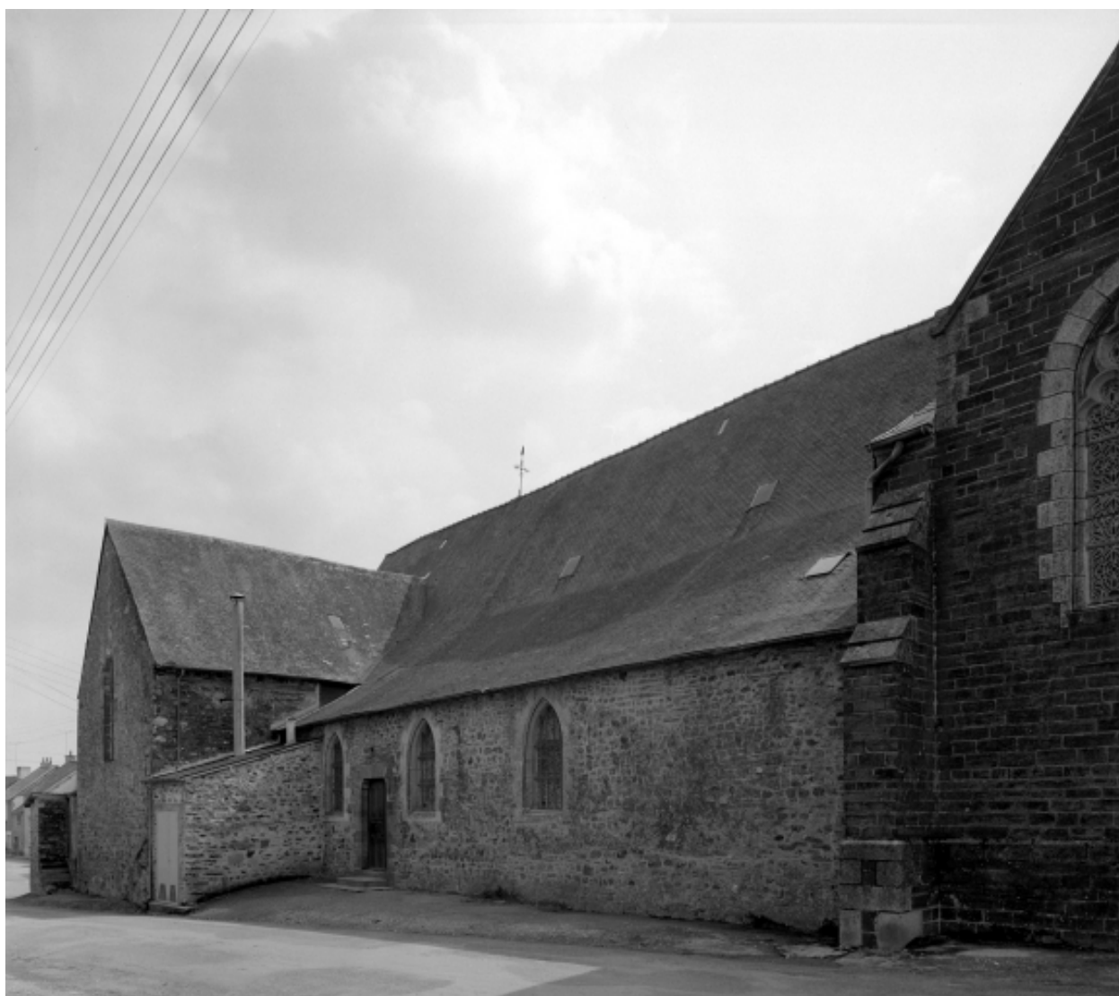
Elévation Nord, partie Est : vue générale
