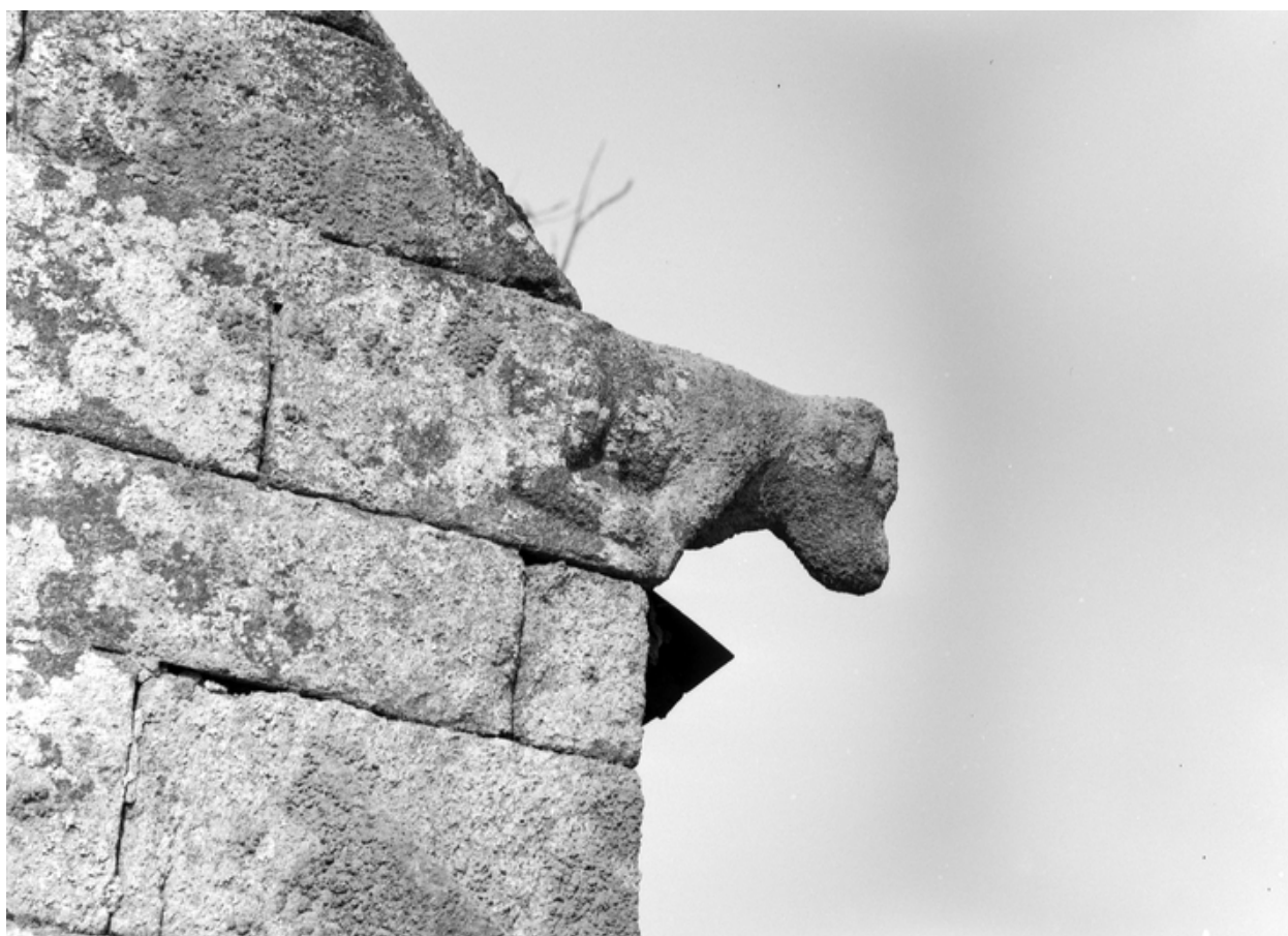
Pierre d'assise : nord-est du rempant du chevet
