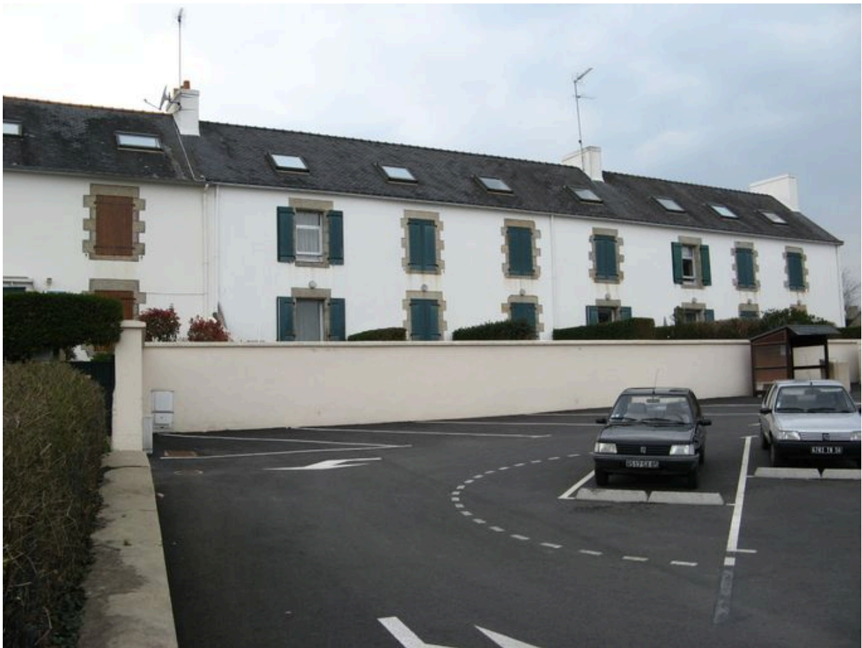
Partie droite de l'ancienne conserverie Peyron côté quai
