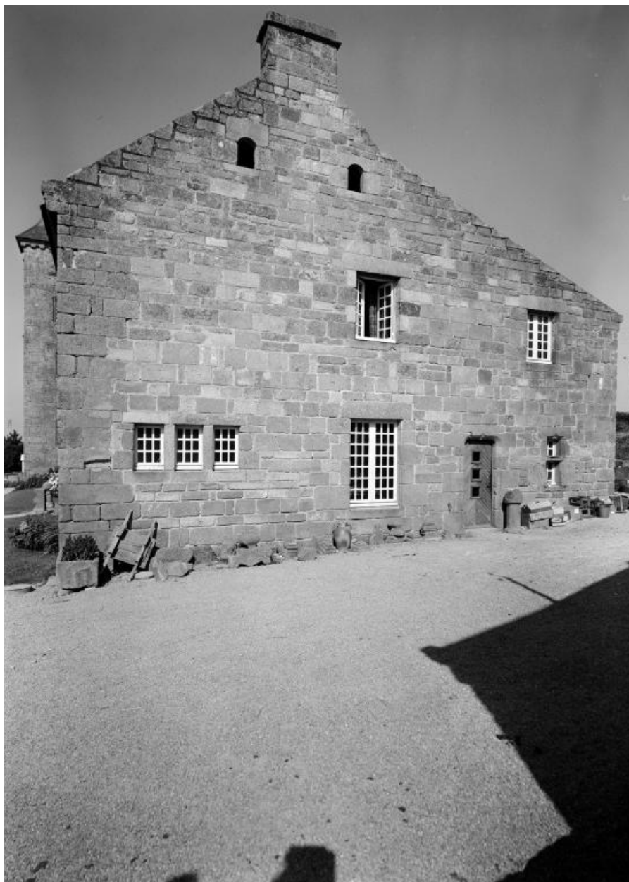
Vue d'ensemble du pignon et des ouvertures
