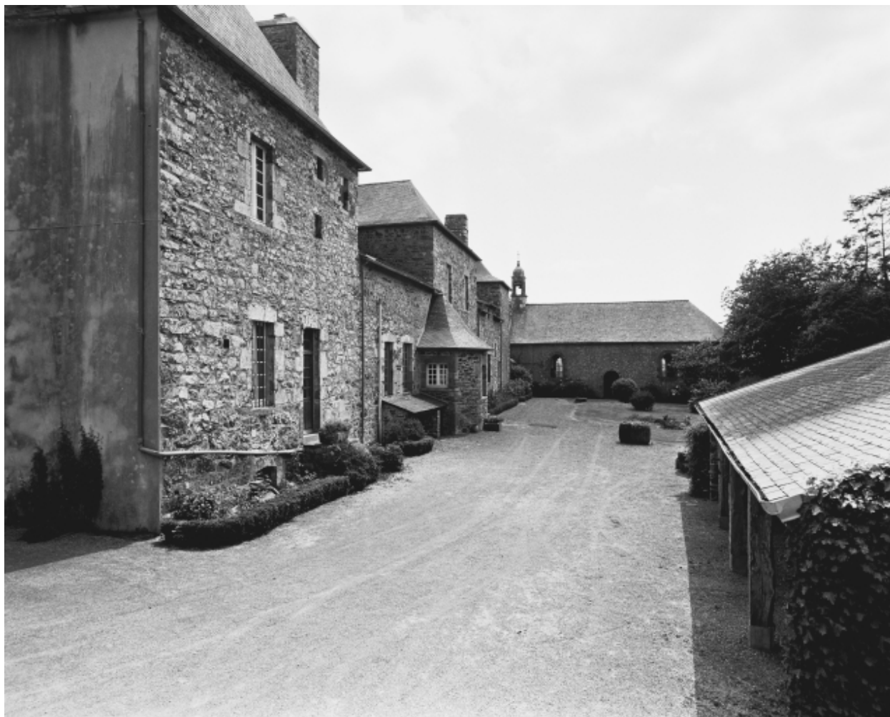
Logis, élévation ouest et élévation nord de la chapelle
