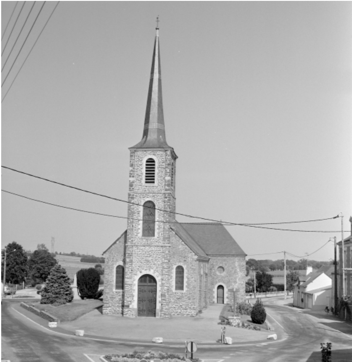
Elévation Ouest : vue générale
