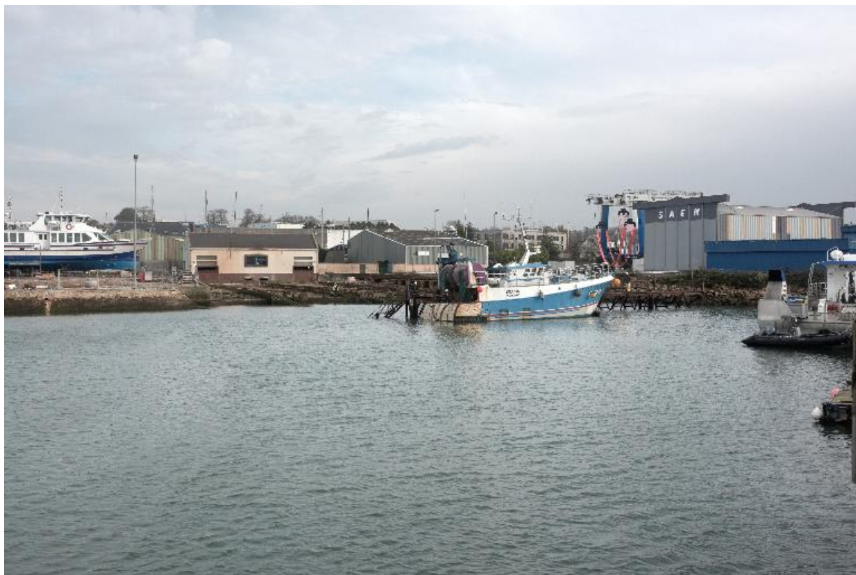
Zone portuaire, vue générale
