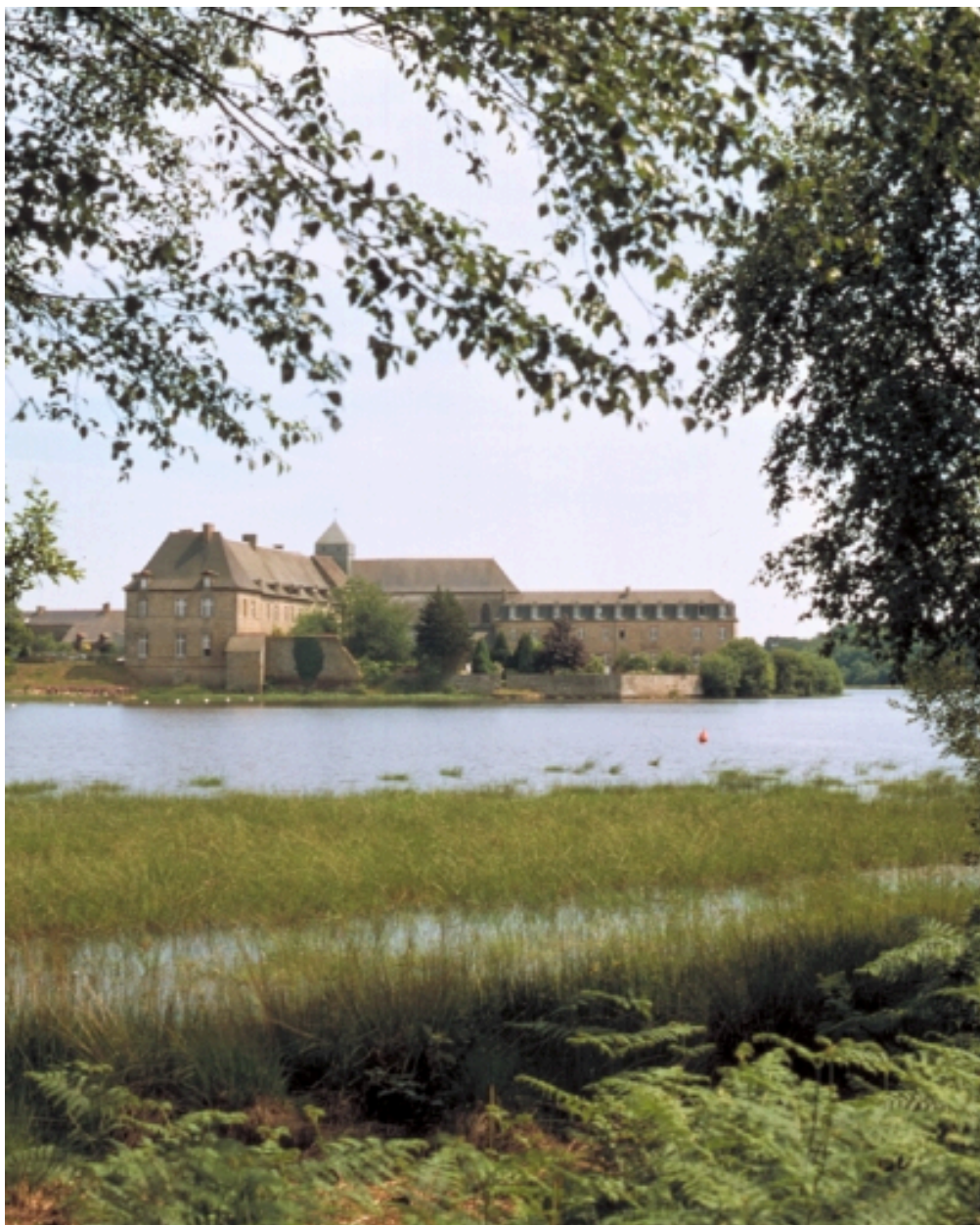
Vue de situation nord
