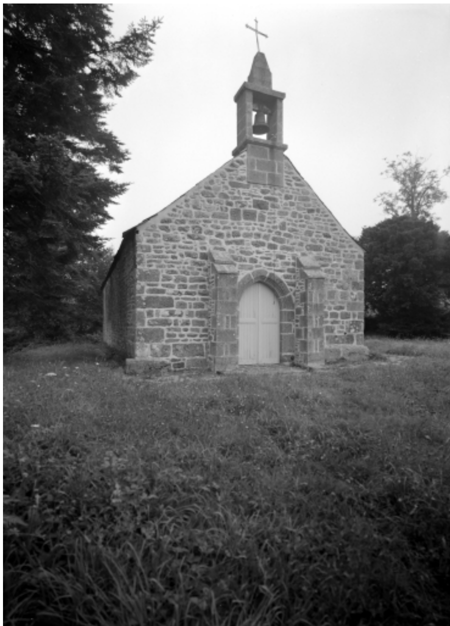
Vue de la façade occidentale
