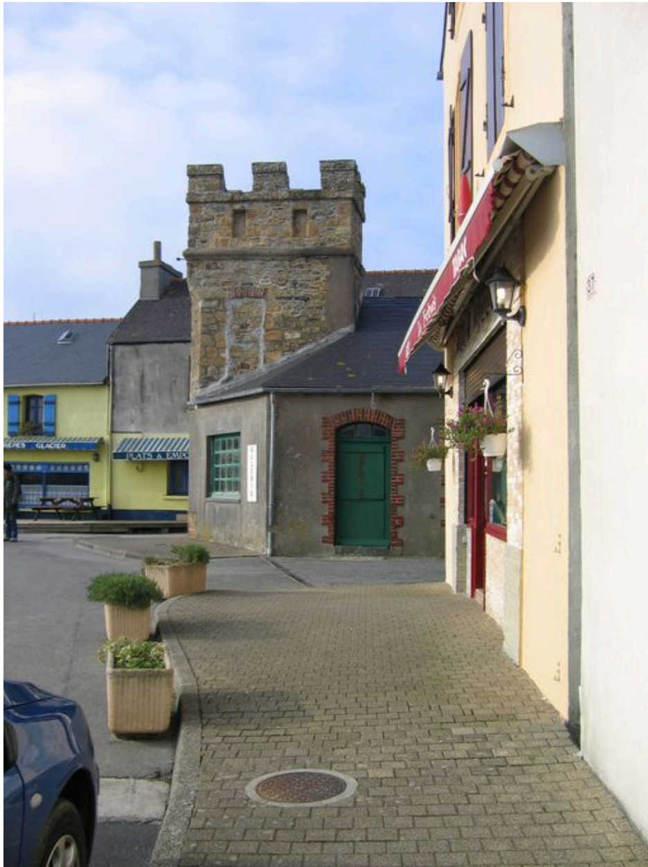
Vue latérale de la Tour du Fret
