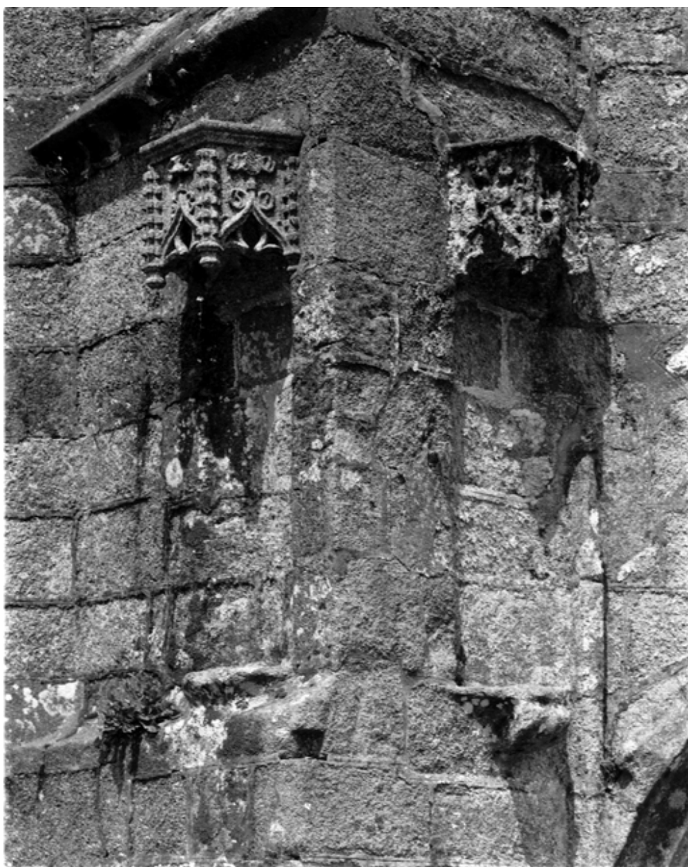
Pignon du bras sud du transept, détail : niches décorant le contrefort ouest du pignon est
