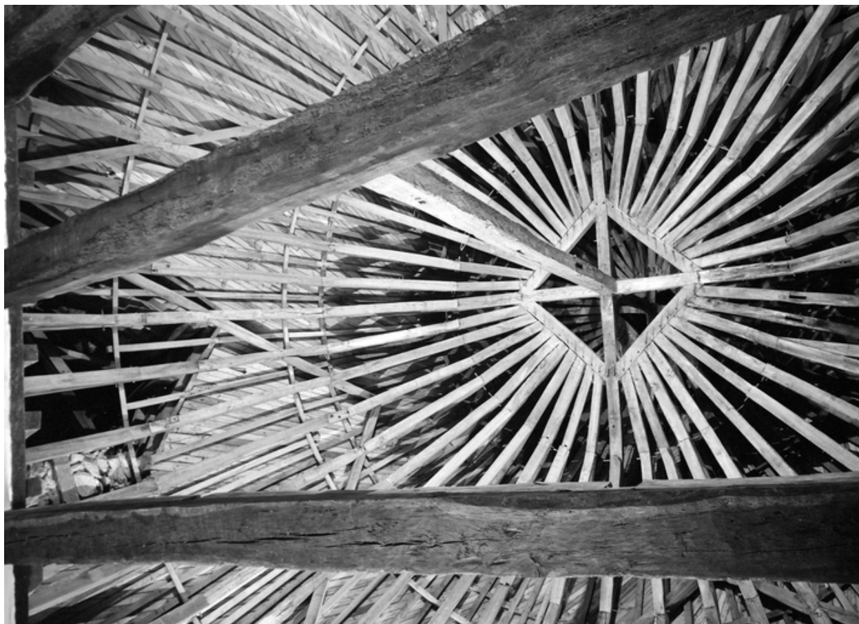
Tour sud-ouest, troisième niveau, charpente, détail enrayure.
