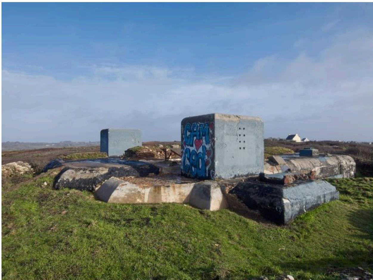
Vue générale du bunker - abri de type 485 long pour radar Mammut depuis le sud-ouest. De la dalle de couverture émergent deux imposants puits pour câble d'antenne et les vestiges des quatre mâts d'antenne. Le bunker est doublé en brique
