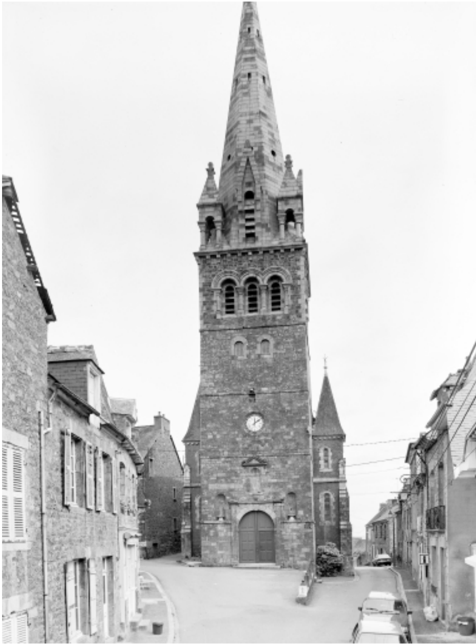
Elévation Ouest : vue générale
