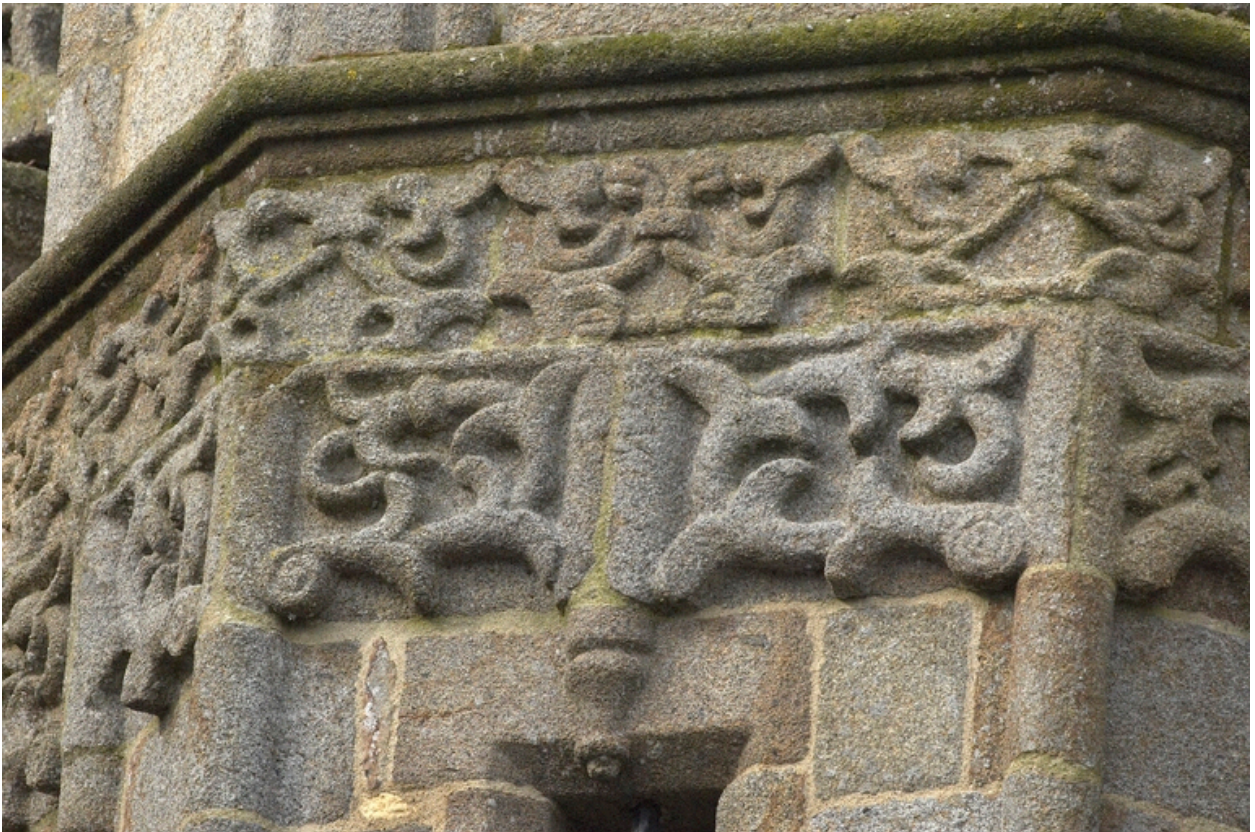
Tour nord, détail décor du bandeau du second étage
