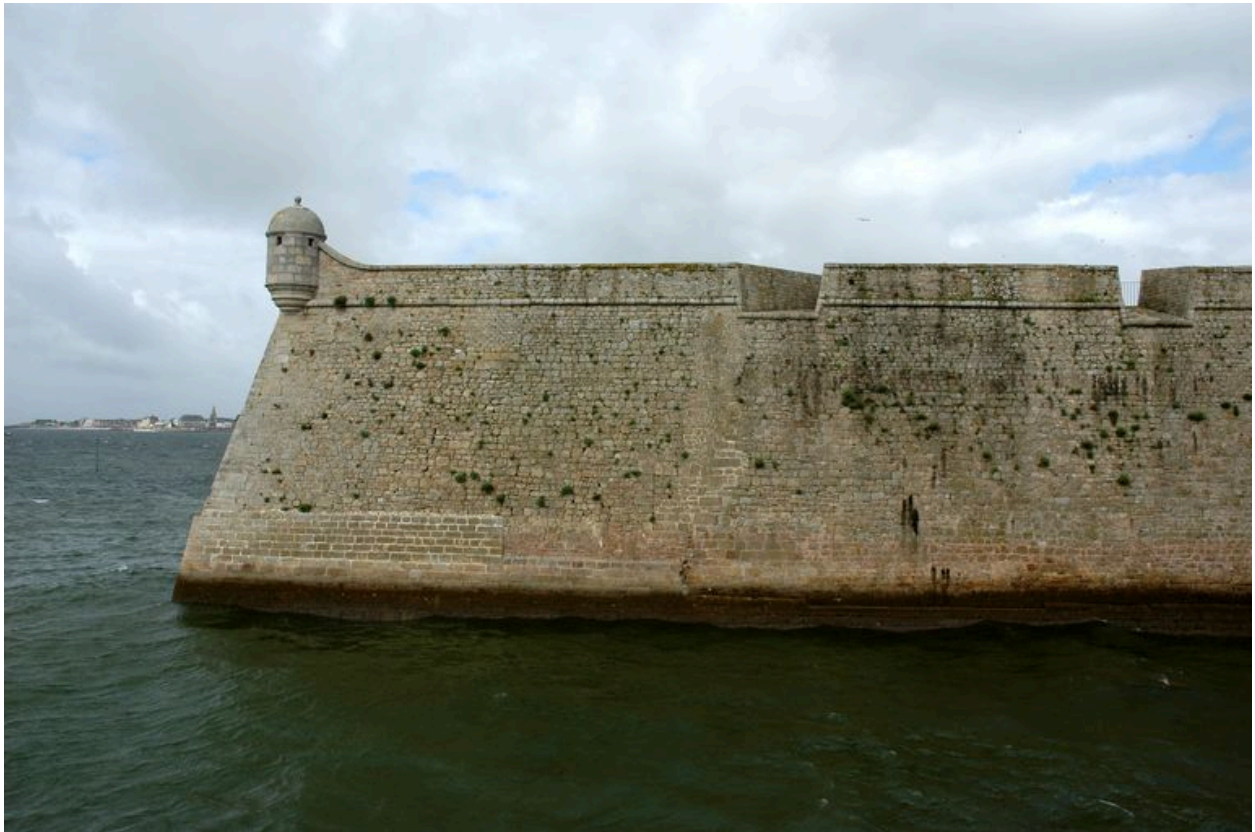
Vue de la citadelle de Port-Louis : embrasures plongeantes et échauguette du bastion de Groix
