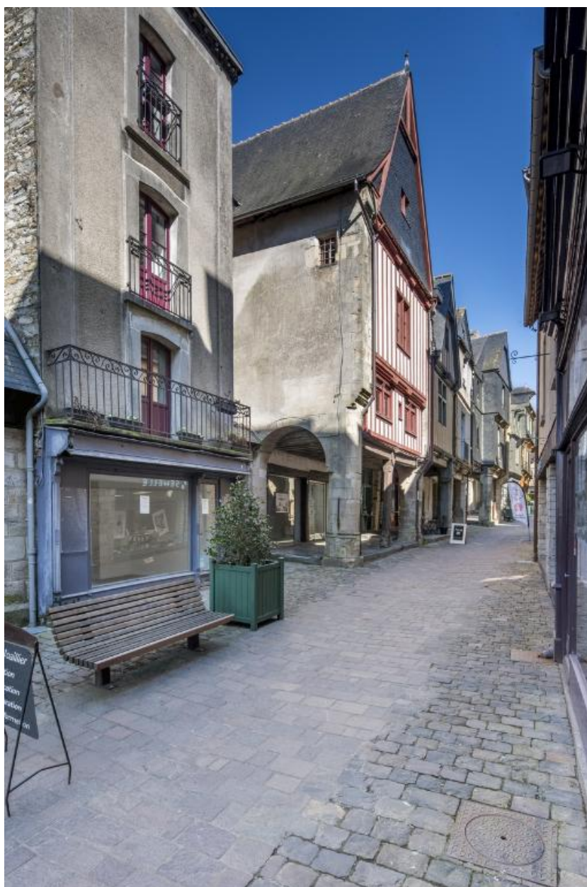
Vue de situation de l'édifice en pan de bois.
