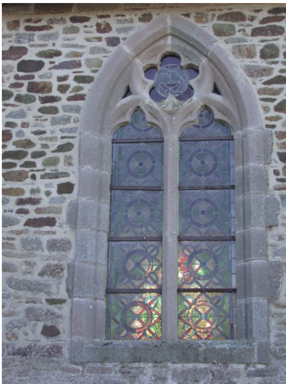
Nef, mur nord, ( baie 7)
