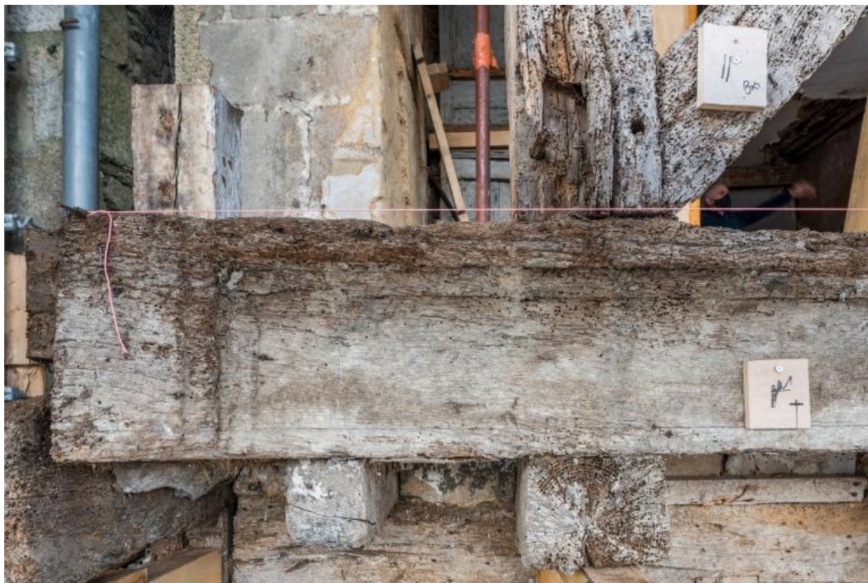
Détail des moulures de la sablière basse du deuxième étage (restauration en 2021).
