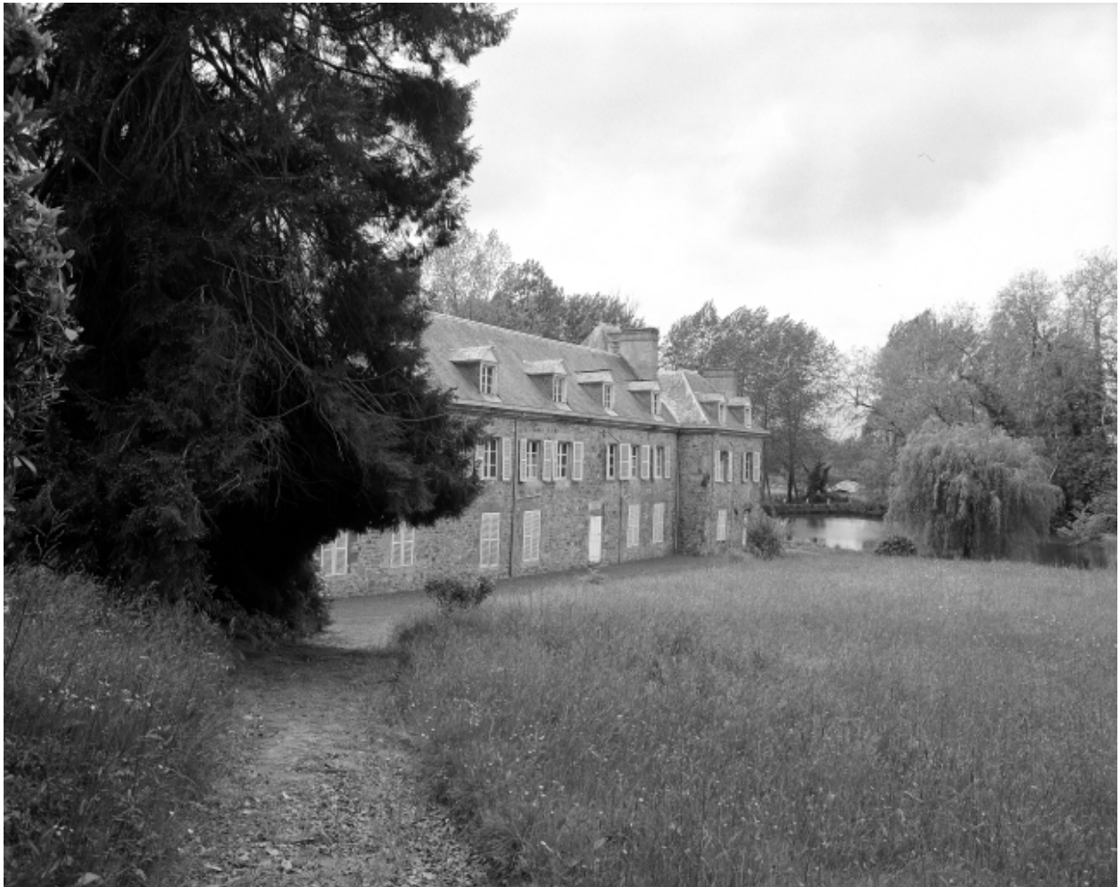
Façade postérieure, vue générale nord-est.
