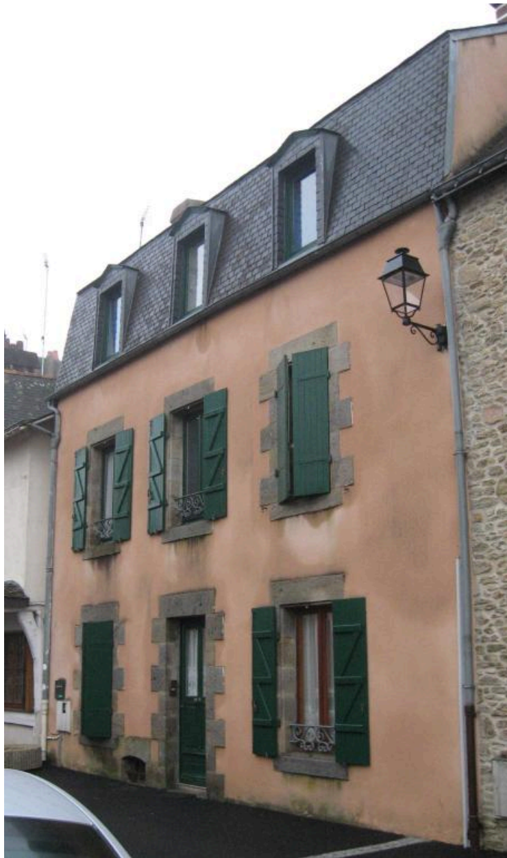
Maison, 4 Grande rue, vue générale
