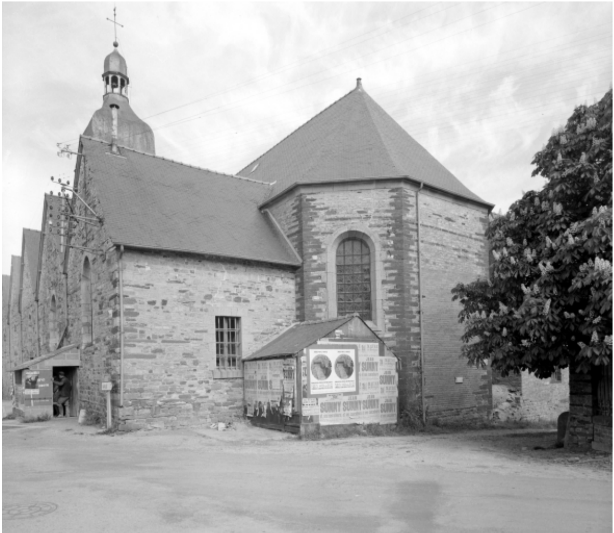
Elévation Est : vue générale
