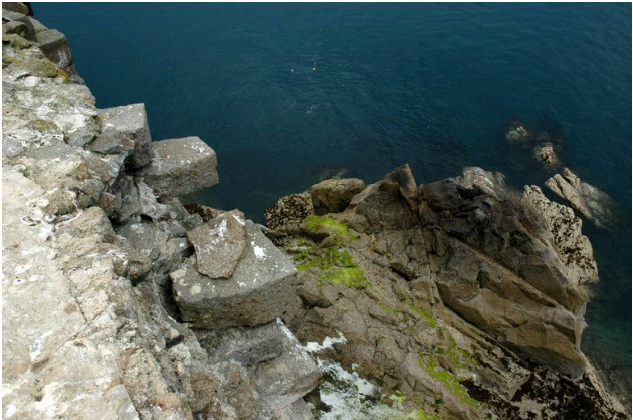
Vue du fort de la Conchée : parapet de la plate-forme d'artillerie (batterie haute)
