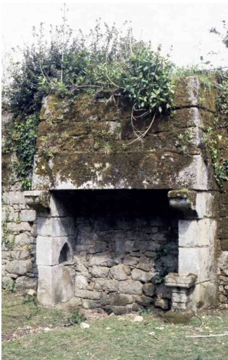
Cour intérieure, mur est, cheminée. (1989)
