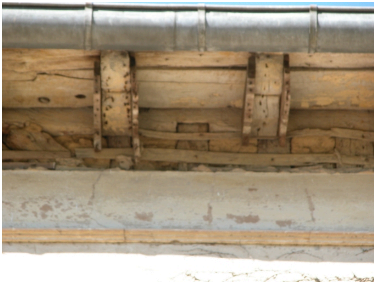
Détail de la corniche.
